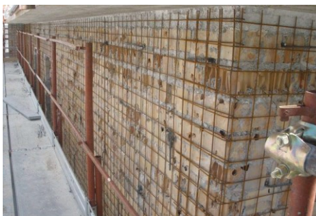
Fig. 124 - Intervento con intonaco armato tradizionale
