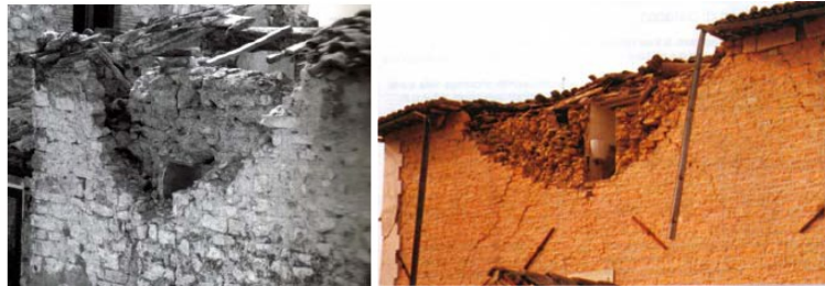
Fig. 34 - Flessione orizzontale di parete a doppia cortina
