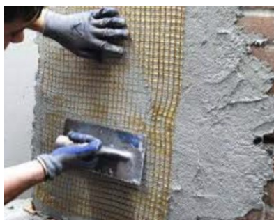
Fig. 127 - Intervento con FRCM
