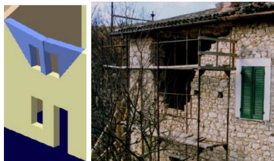
Fig. 33 - Meccanismo di flessione orizzontale (a) e collasso (b)
