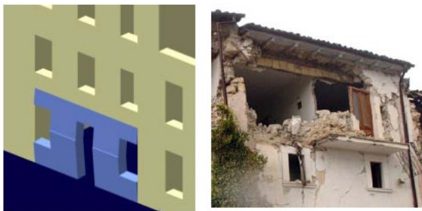
Fig. 23 - Flessione verticale di parete ad un piano
