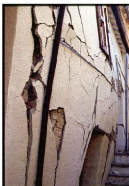
Fig. 22 - Dissesti di meccanismo di flessione verticale
