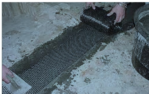
Fig. 126 - Intervento con FRP
